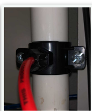
Abwasser-Anschluss-Schelle (Einbaubeispiel)
